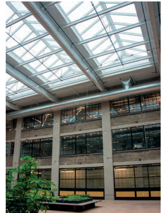
500 Seneca St, Buffalo, USA. 128 modules.
